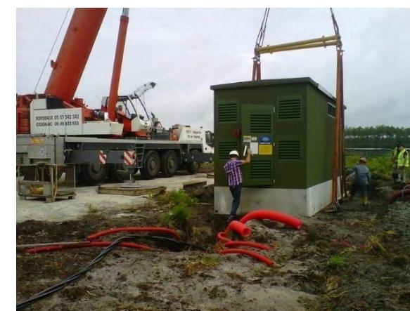
Figure 122 : Exemple de déchargement d'un poste de livraison
