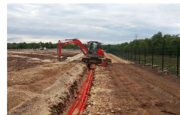
Figure 120 : Exemple d'enfouissement de câbles électriques HTA
