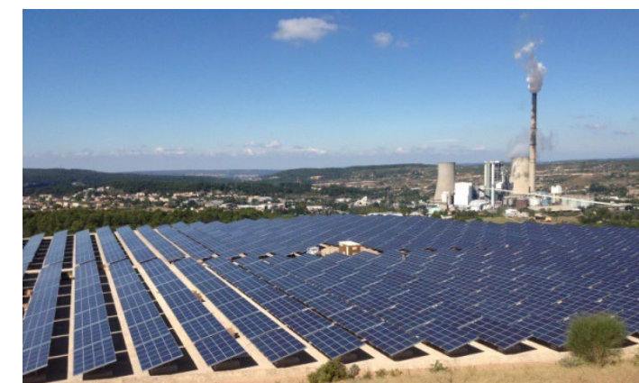
Figure 109 : Réalisation Urbasolar : aménagement d'un ancien terrib à Gardanne (13)
