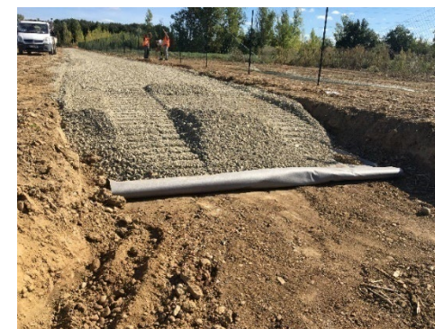
Figure 119 : Exemple de réalisation de voie d'accès interne
